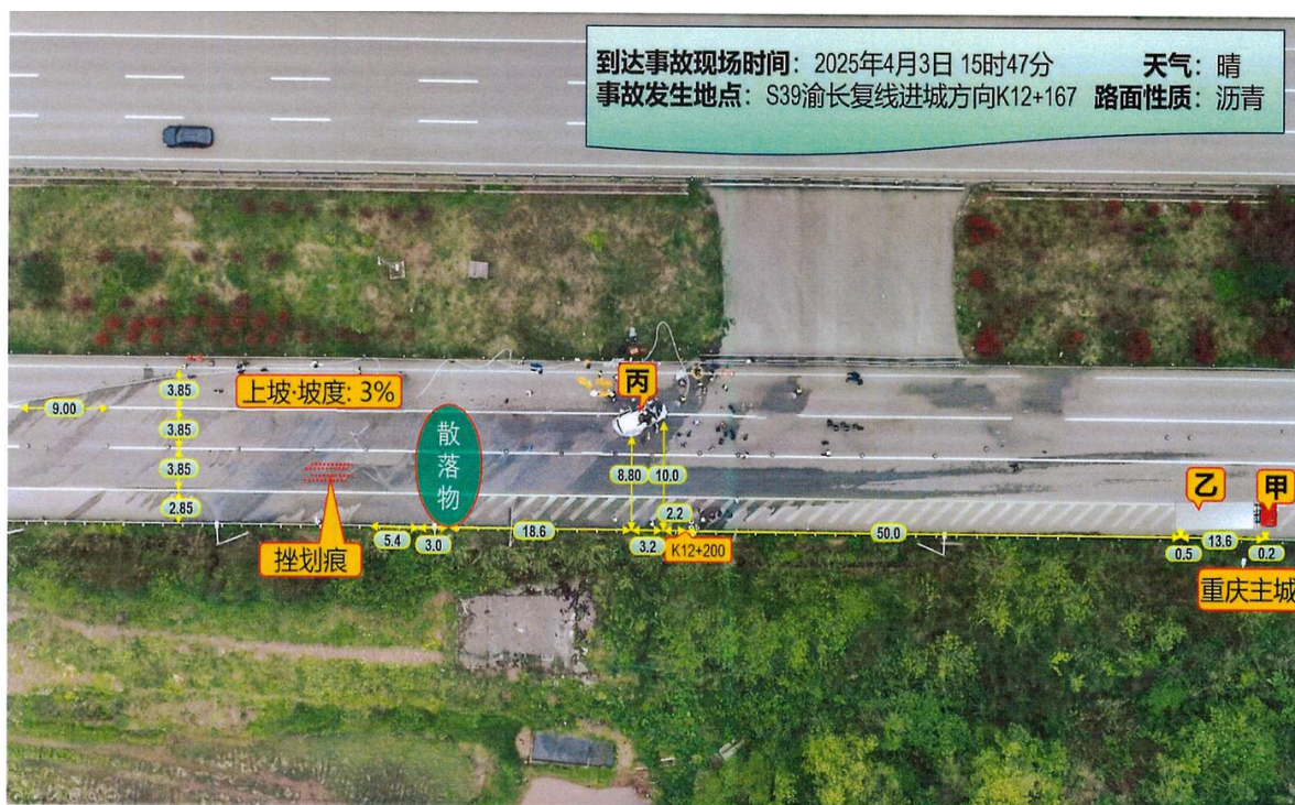
图 3 现场勘察照片
